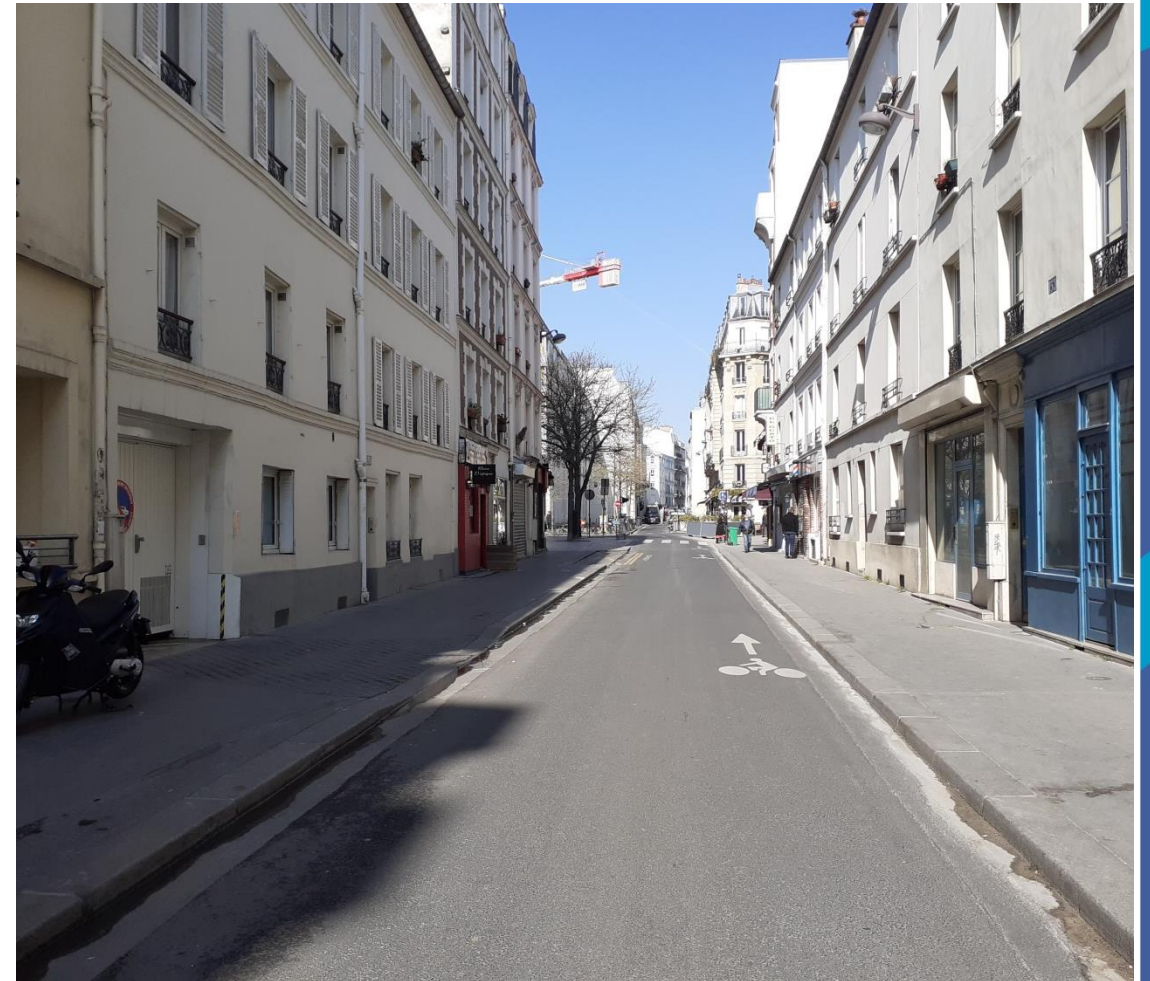
Agrandissement des trottoirs de la rue du Château
