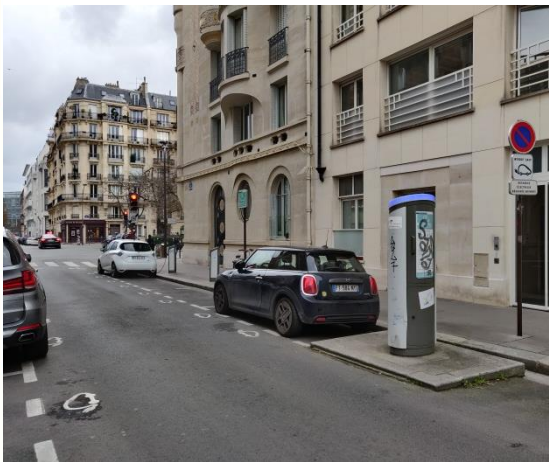
Borne de recharge – rue Boulard
