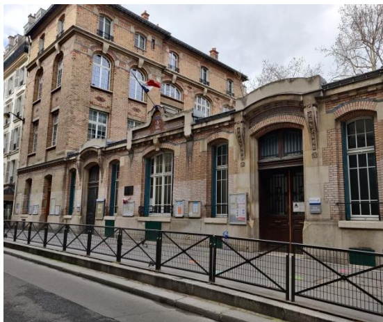
Écoles maternelle et élémentaire – rue Delambre
